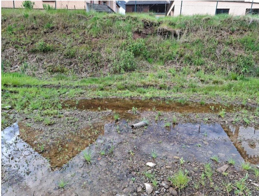
Abbildung 4: Temporäre Wasserpfützen im östlichen Plangebiet
