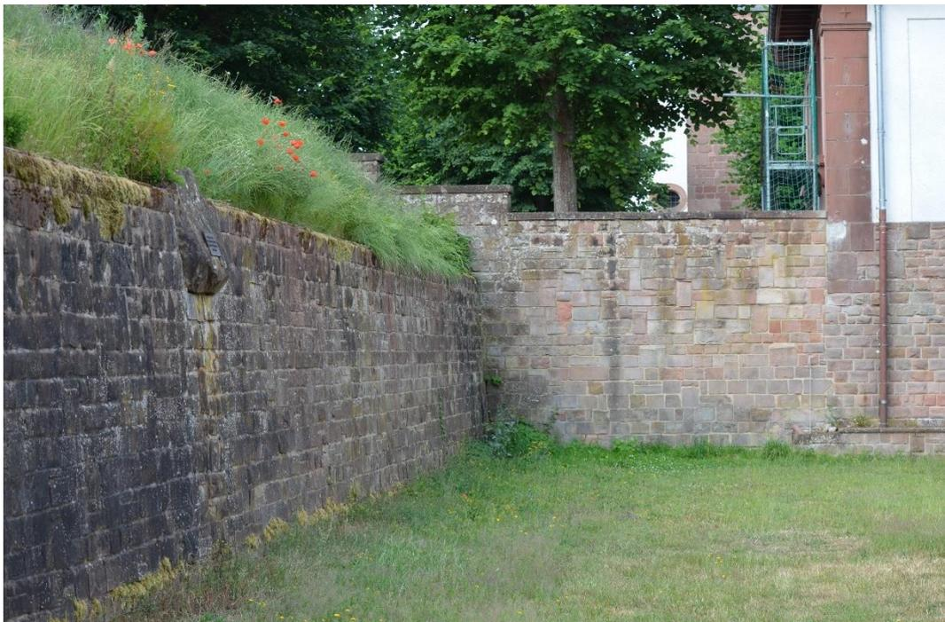
**Abbildung 3: Eine mit Natursteinen verblendete Betonmauer**
