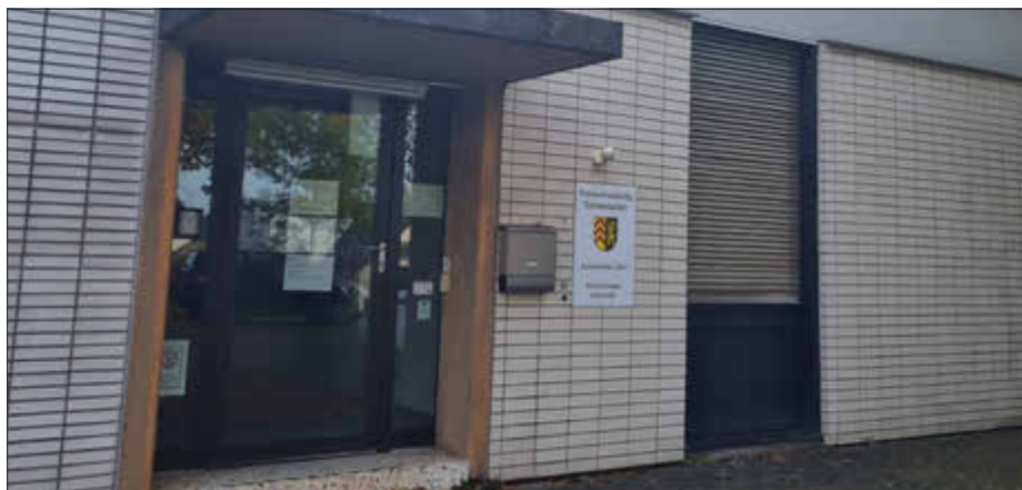
Eingangsbereich des neuen Jobcenter-Standorts in Dahn.
