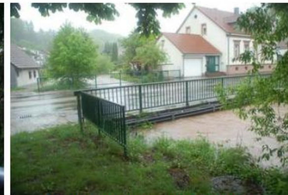
Die Moosalbe erreichte an der Brücke die die beiden Ortsteile von Waldfischbach-Burgalben trennt bis an die Fahrbahnkante
