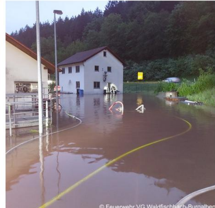
Einsatz an der Kläranlage nach Überflutung der Pumpentechnik
