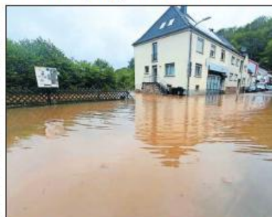
Die Alleestraße in Burgalben wurde überflutet. Später wurde auch die Höhenindstraße gesperrt. FOTO: ANDREA DALIM
