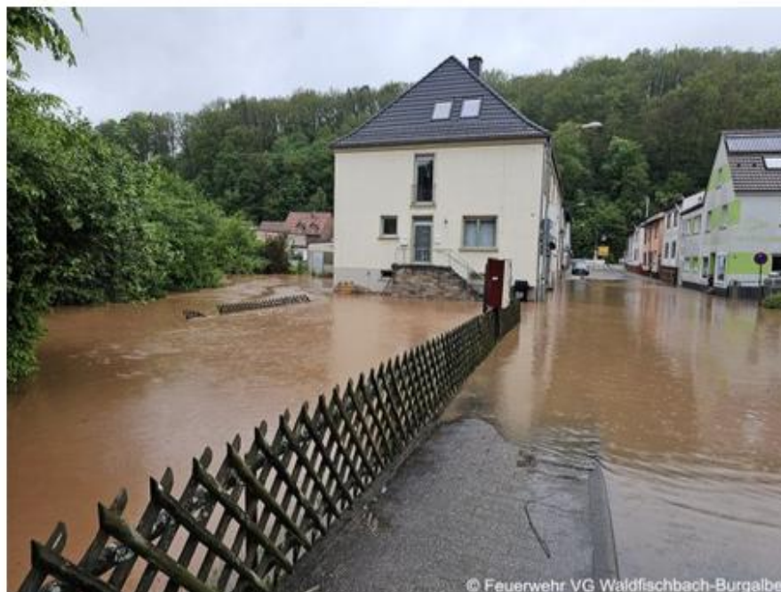
Überflutung Alleestraße im Bereich Friseursalon
