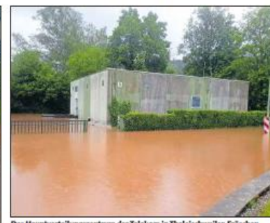
Das Hauptverteilungszentrum der Telekom in Thaleischweiler-Fröschen stand unter Wasser. FOTO: ADD
