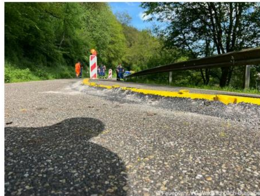
Sicherungsmaßnahmen Hangrutsch K24
