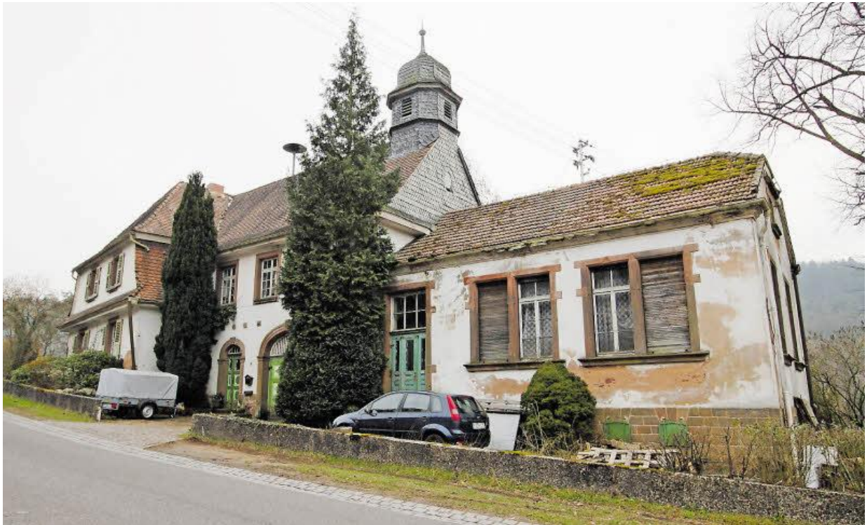
Abbildung 8 : Ehemalige Schule Quelle: https://www.rheinpfalz.de
