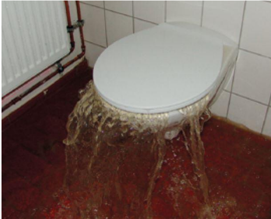
Bild: Überlaufende Toilette durch Kanalrückstau. Foto: THW
